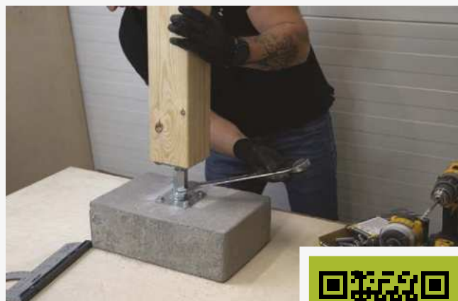
8 Regulacja wysokości odsadzenia słupa od betonu.
