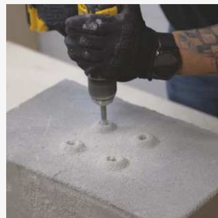
6 Rozwiercenie otworów w betonie.
