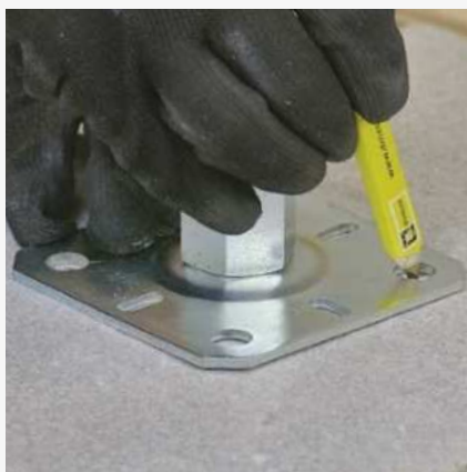
5 Przyłożenie dolnej płytki podstawy i wyznaczenie miejsc wiercenia w betonie.
