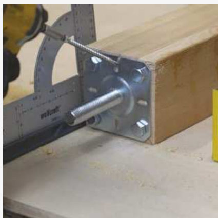
4 Dodatkowe otwory fasolowe pod wkręty z pełnym gwintem, mocowanie pod kątem około 30°.
