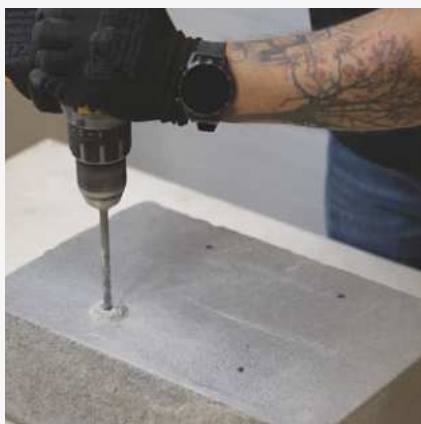
2 Rozwiercenie otworów w betonie.
