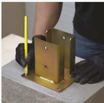
1 Wyznaczenie miejsc otworów pod kotwy pierścieniowe.
