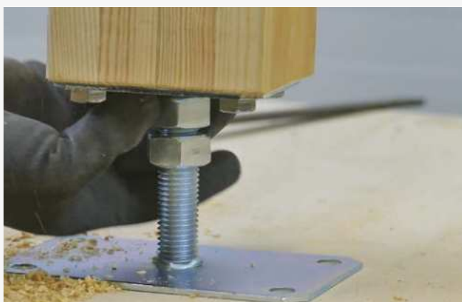
6 Nałożenie słupa na pręt gwintowany zespolony z płytą dolną.
