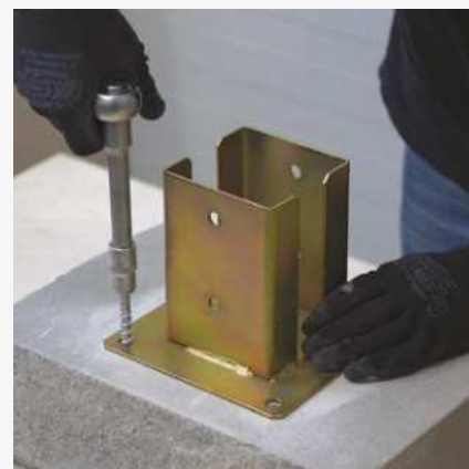
3 Zamocowanie podstawy w betonie.
