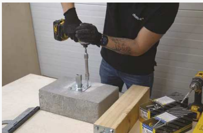
7 Przykręcenie dolnej płytki za pomocą śrub do betonu.
