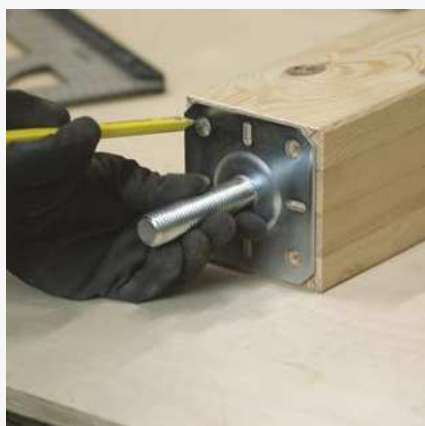
1 Zaznaczenie miejsc pod wkręty do drewna.
