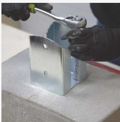
5 Zamocowanie podstawy w betonie.
