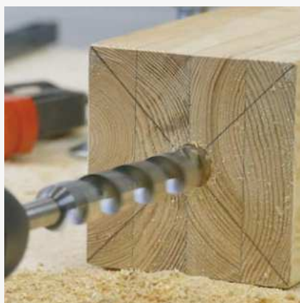
2 Rozwiercenie otworu pod pręt gwintowany.
