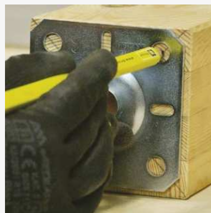
3 Zaznaczenie miejsc pod wkręty do drewna.
