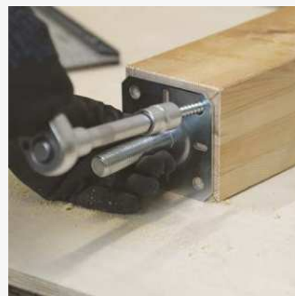
3 Zamocowanie płytki górnej do spodu słupa.
