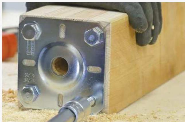
5 Zamocowanie płytki górnej do spodu słupa.
