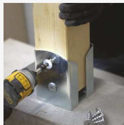
6 Osadzenie słupa w podstawie i przykręcenie wkrętami do architektury ogrodowej.
