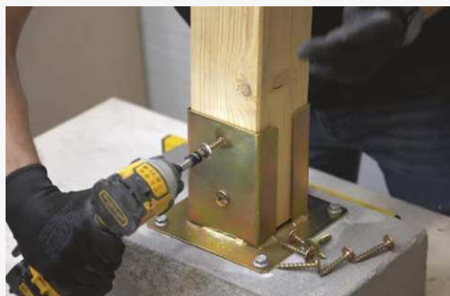
5 Przykręcenie słupa wkrętami do architektury ogrodowej.
